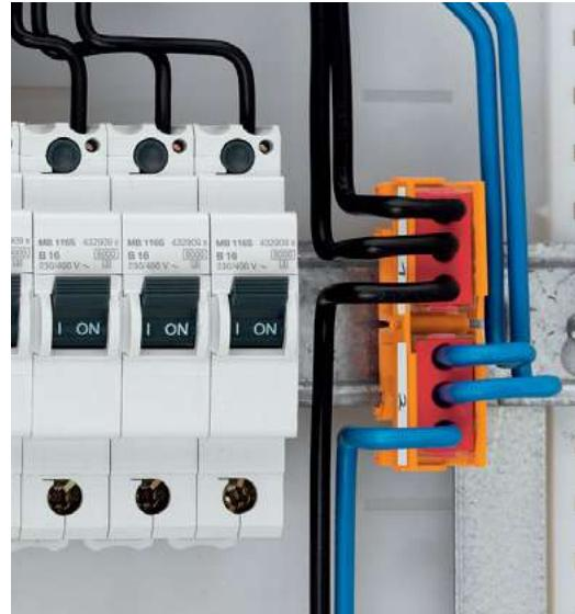
Для подключения светильников к алюминиевым проводникам сечением 2,5  $\text{мм}^2$  используются клеммы WAGO серии 224, которые поставляются уже заполненными пастой Alu-Plus – артикулы 224-111 и 224-122.
